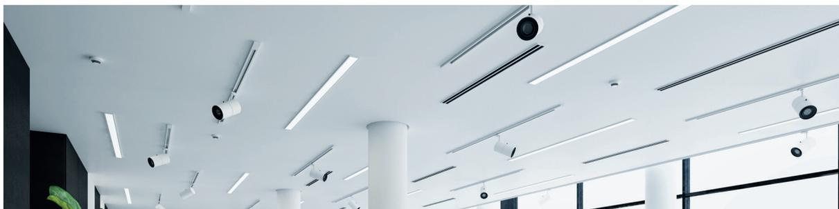
Корпус прожектора вращается на 90° относительно вертикальной оси и на 360° относительно горизонтальной оси. В линейке прожекторов PTR 07 представлены две цветовой температуры 3000 К и 4000 К.
